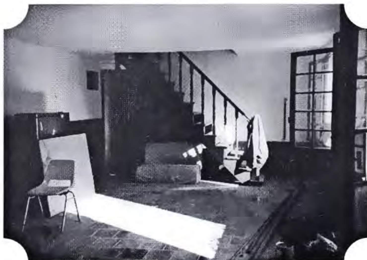
L'intérieur de la ferme des cavaliers
