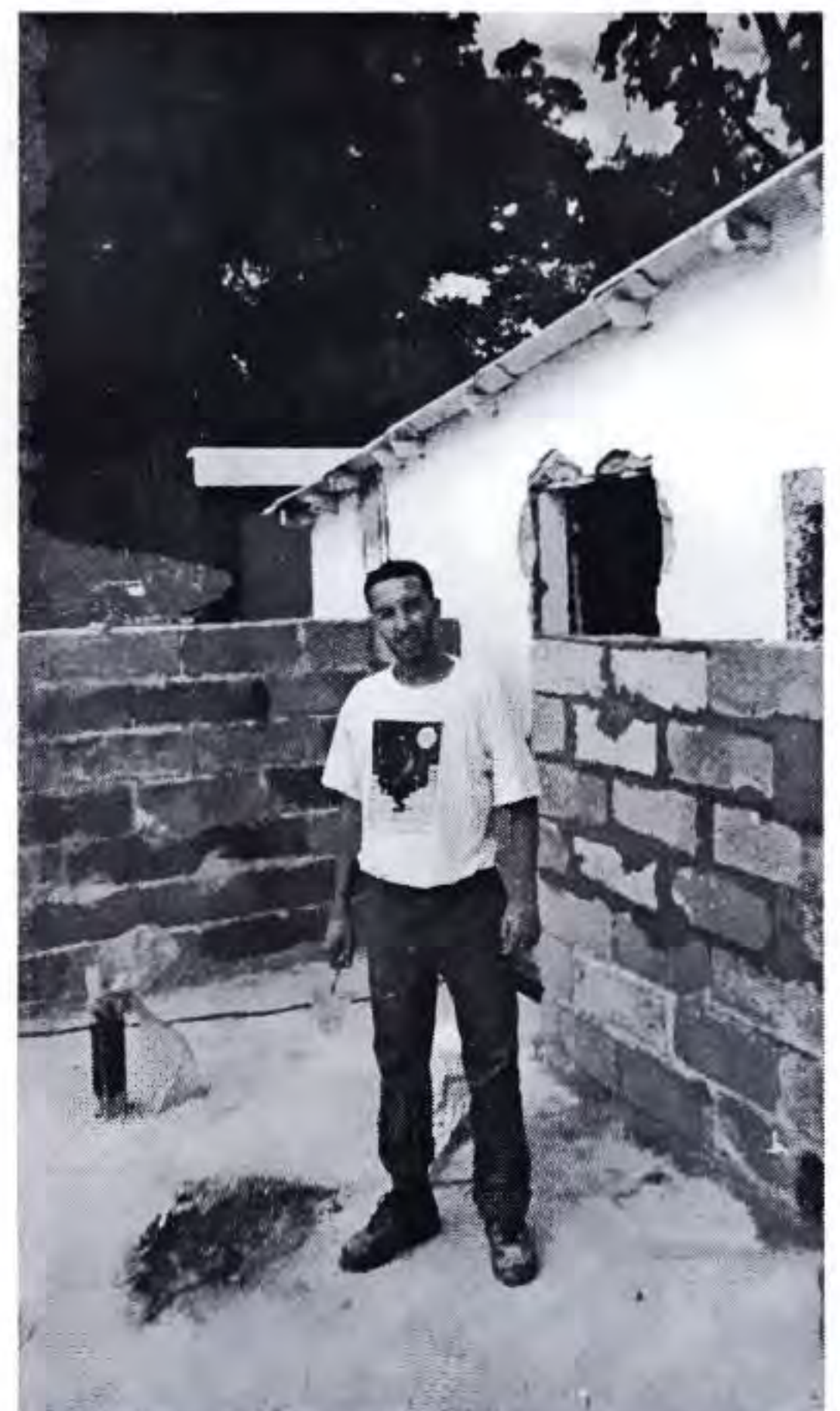
Mokthar, un aide maçon qui construit la cuisine
